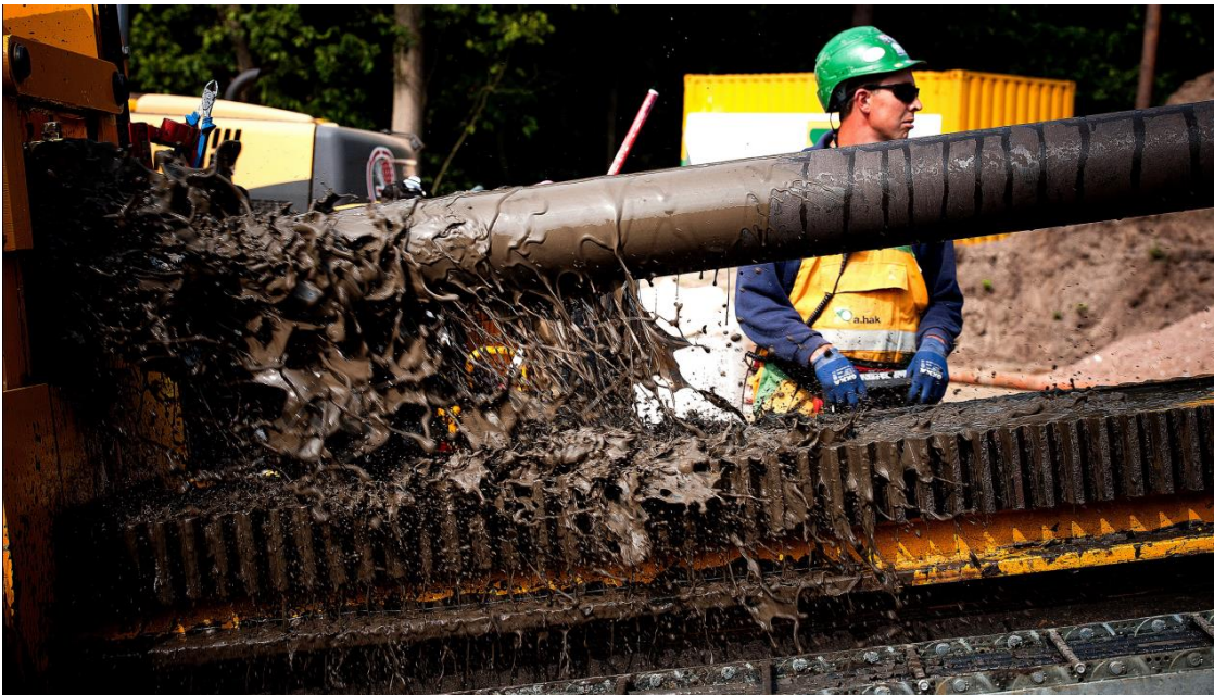
Foto 1. Boorinstallatie met Bentoniet boorvloeistof.
